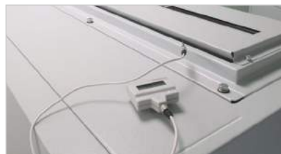
Messung der Temperatur der Luftaustrittsströmung
